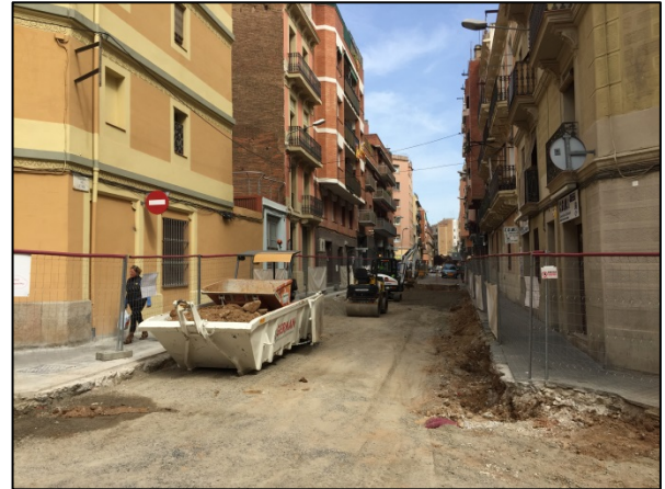
Foto 14. Rebaix tram 1 sector oest
