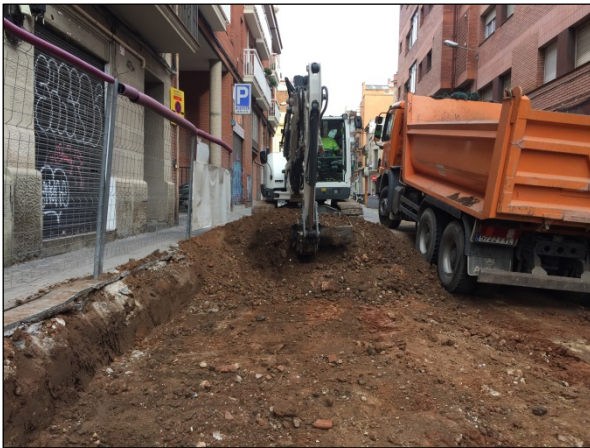
Figura 20. Treballs de rebaixa
