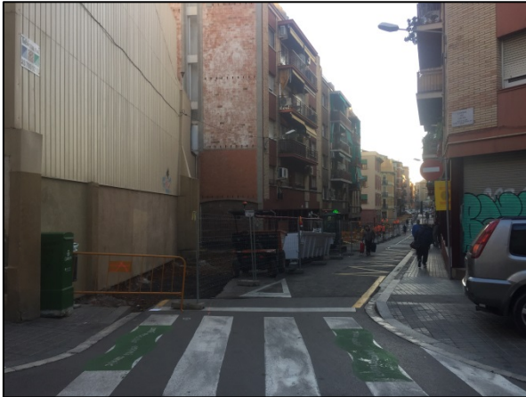
Foto 01. Estat inicial tram 1 oest
