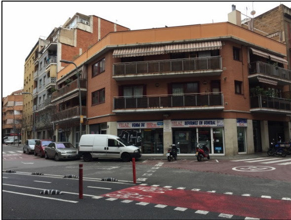
Foto 07. Estat inicial tram 2. Carrer de l'Àliga - sud
