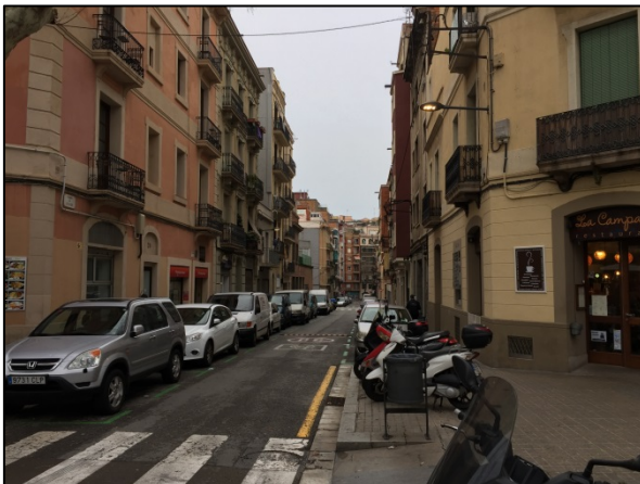
Foto 09. Estat inicial. Carrer de l'Àliga - nord
