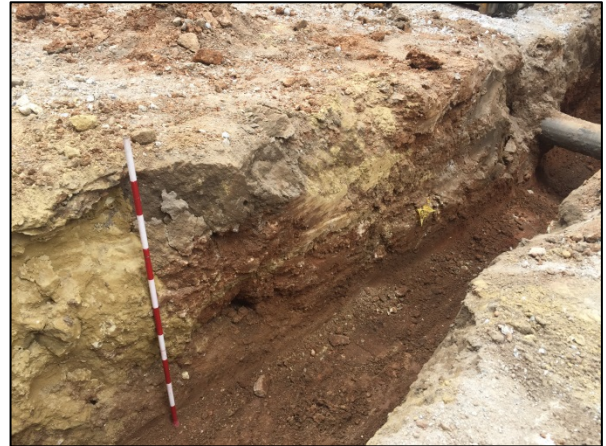
Foto 20. Detall rasa de serveis tram 2
