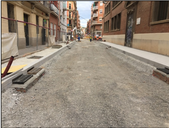
Foto 19. Final del rebaix tram 2.
