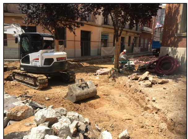
Foto 18. Inici rebaixos tram 2
