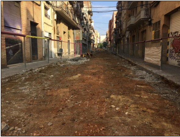
Figura 18. Tram 3 rebaixa general
