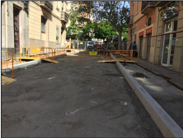
Foto 25. Estat final carrer de l'Àliga amb carrer de Vilardell
