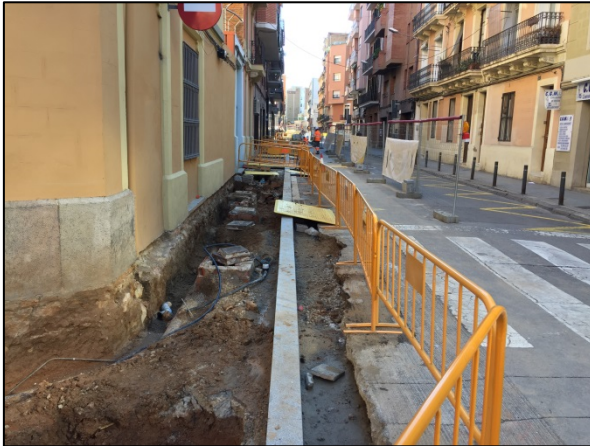
Foto 13. Detall rases serveis tram 1
