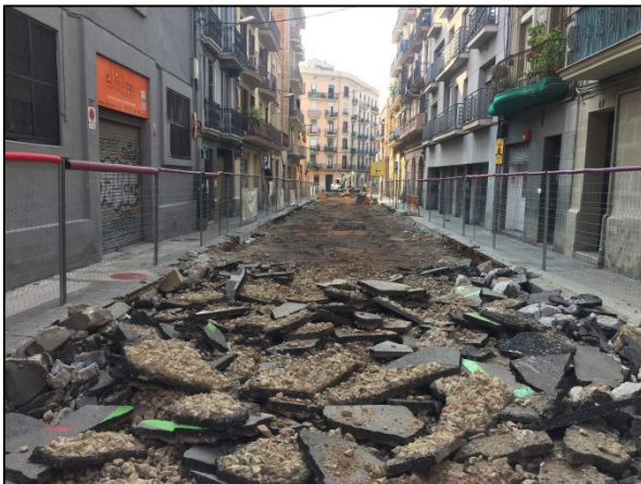
Foto 27. Inici del rebaix al tram 3
