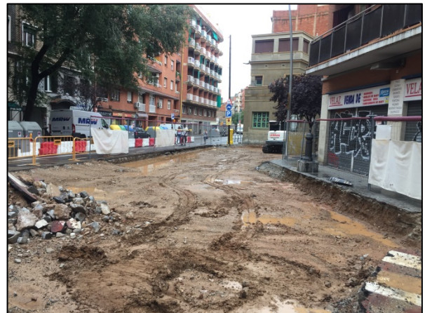
Foto 22. Inici obres rebaix carrer de l'Àliga – tram sud
