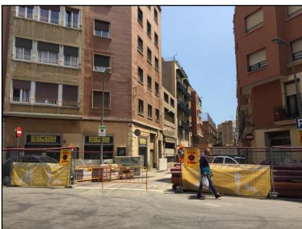
Foto 17. Inici obra tram 2
