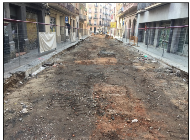
Foto 24. Rebaixos al carrer de l'Àliga- tram nord
